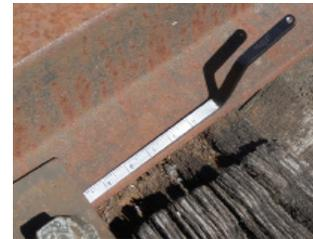
**INDICATEUR de serrage** automatique gradué de 0 à 5 mm - Protection par cadmiage
